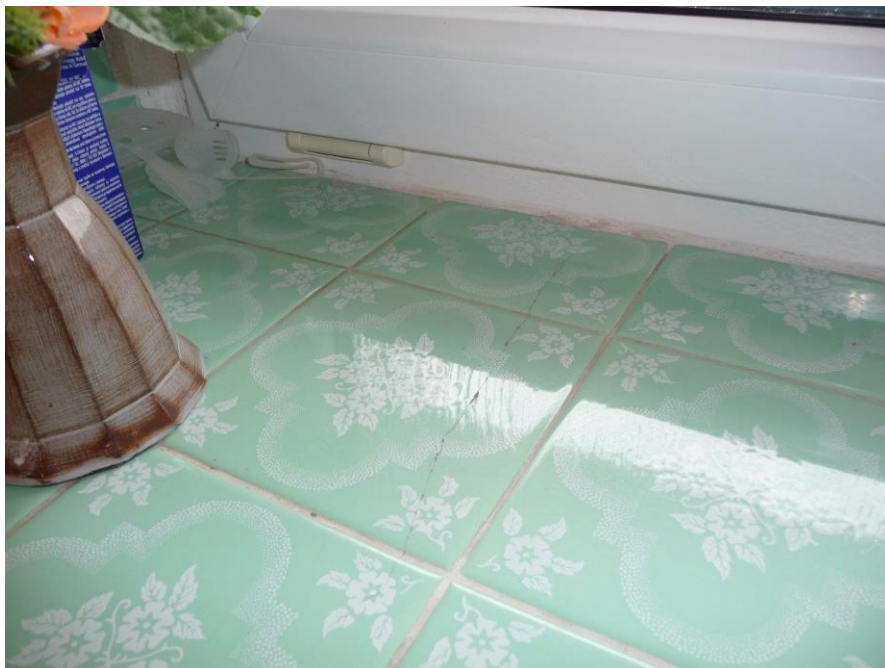
Foto č. 28 – WC v přízemí – trhlina na parapetu
