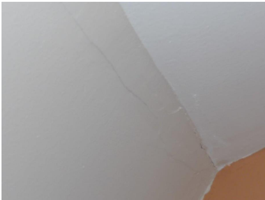
Foto č. 36 – Dětský pokoj v podkroví – trhlina u stropu
