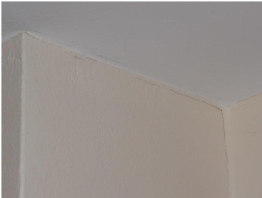
Foto č. 34 – Obývací pokoj - trhlina u stropu u vstupních dveří
