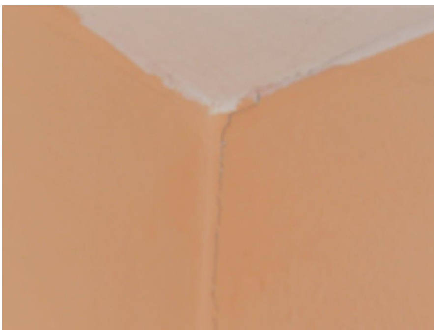
Foto č. 35 – Chodba v podkroví – trhlina u vstupních dveří do obývacího pokoje
