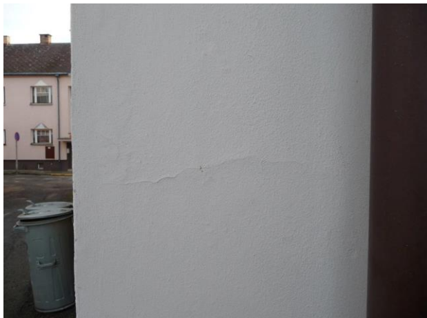
Foto č. 39 – Trhlina ve zdi u garáže
