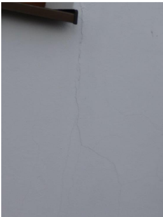
Foto č. 42 – Pohled severní - trhlina pod oknem
