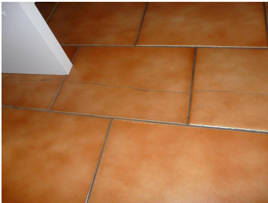
Foto č. 26 – Obývací pokoj v přízemí – trhlina v podlaze
