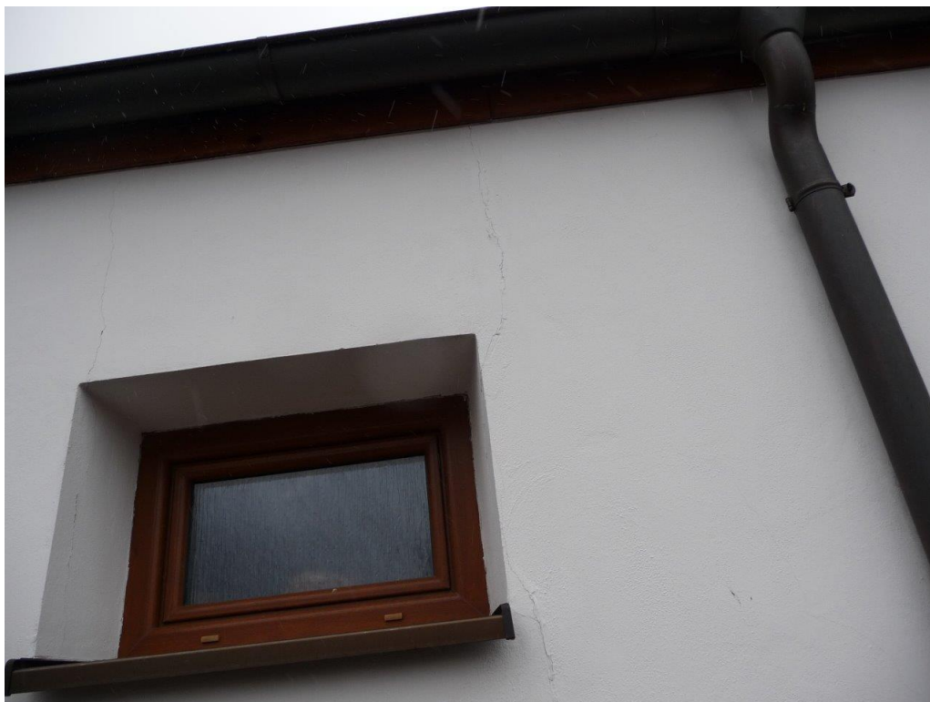
Foto č. 41 – Pohled severní - trhliny u okna
