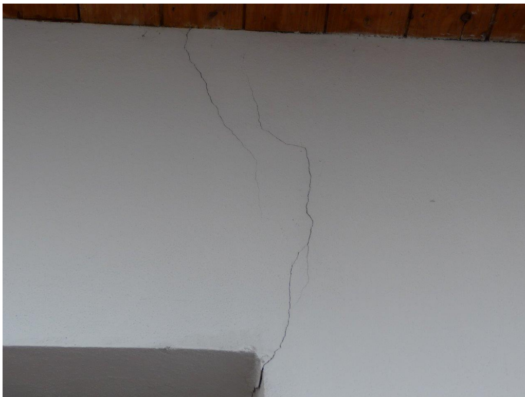
Foto č. 40 – Pohled severní - trhlina nad vstupními dveřmi
