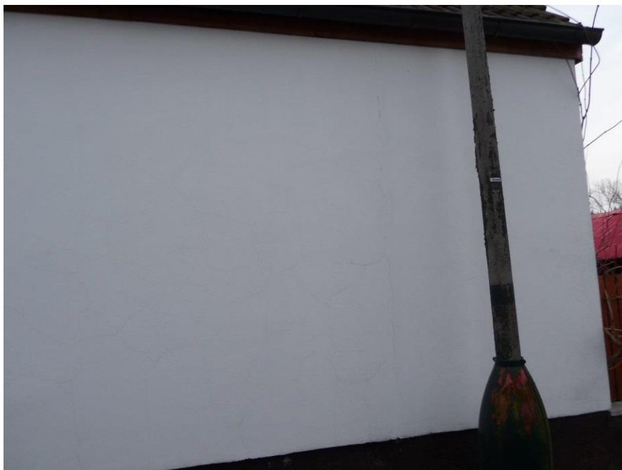
Foto č.45 – Pohled severní - trhliny po celé ploše
