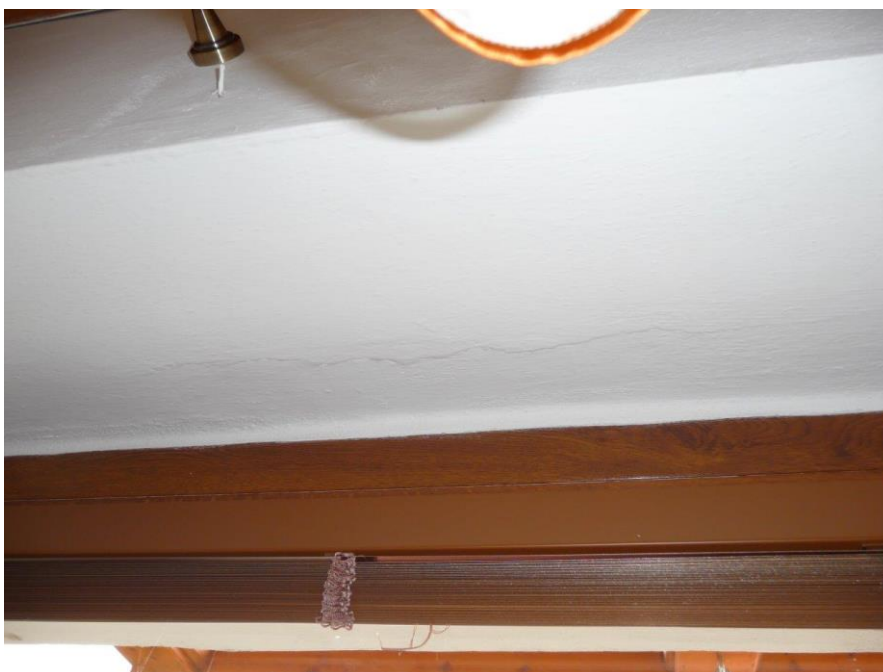
Foto č. 29 – Obývací pokoj v přízemí – trhlina nad oknem
