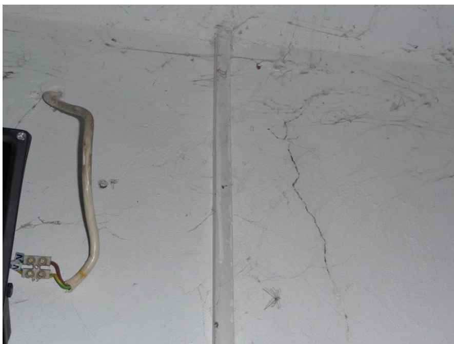
Foto č. 38 – Garáž – trhlina nad dveřmi do garáže
