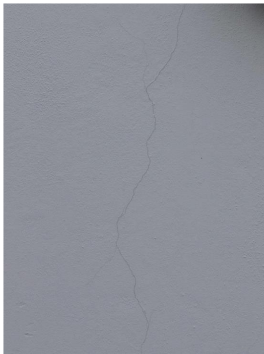
Foto č. 43 – Pohled severní - trhlina mezi okny
